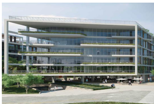
Ilustración 10: Edificio YOO Cumbayá Fuente 7: https://www.yoocumbaya.com/es/yoocumbaya/oficinas/
