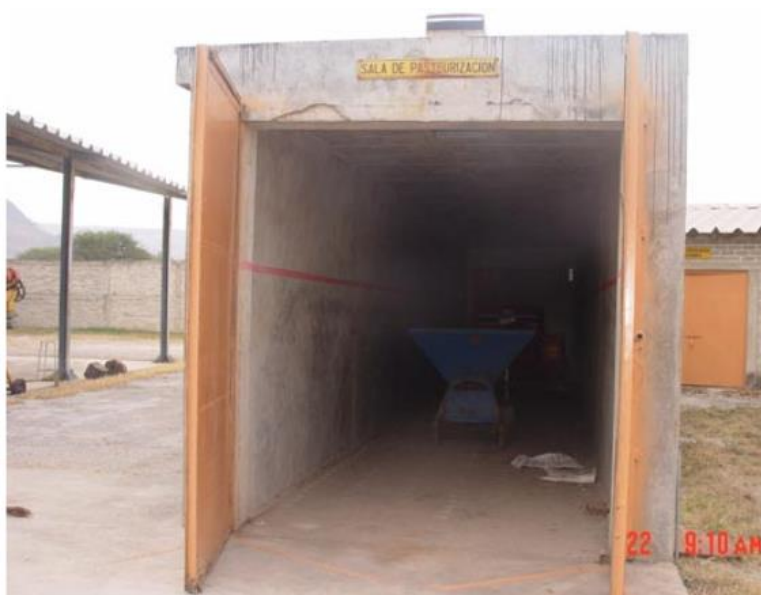
Figura 27. Cuarto de pasteurización
